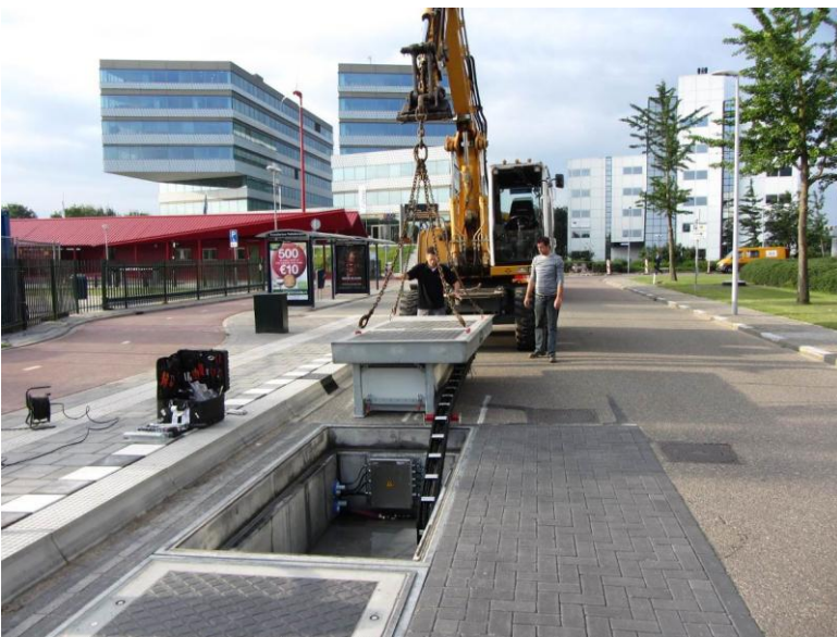
BU: Einsetzen eines 60 kW-Lademoduls an einer Busstation mit 120 kW Leistung (Conductix-Wampfler)
