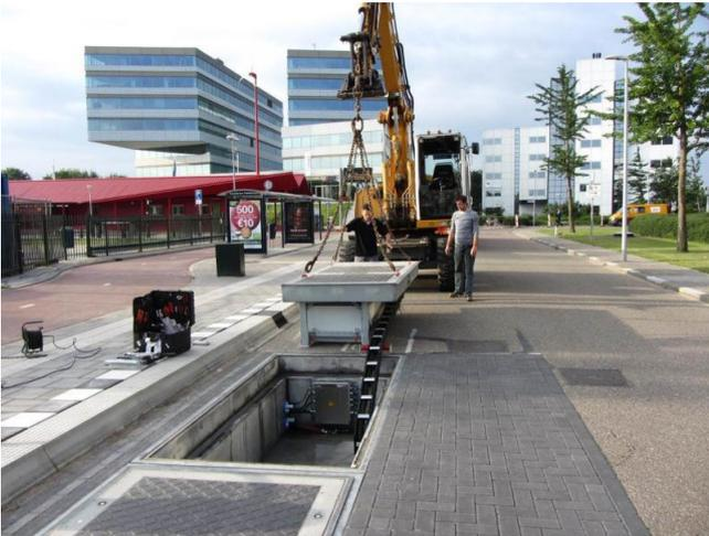
BU: „Inductive Power Transfer“ (IPT®) im Einsatz für Elektrobusse: Einsetzen eines 60 kW-Ladomoduls an einer Busstation mit 120 kW Leistung. Dieses Segment wird zukünftig die IPT Technology GmbH bedienen.
